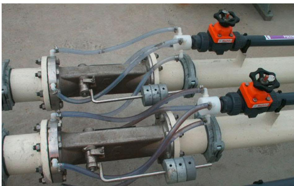
▲ Mélangeur Venturi, système de floculation en ligne
