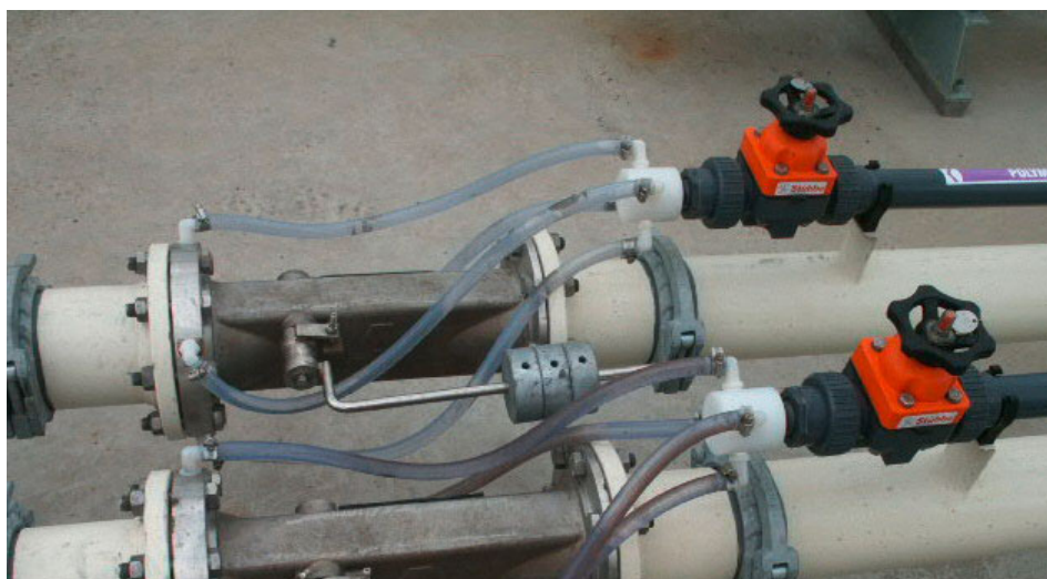
▲ Venturi mixer, sistema di flocculazione in linea
