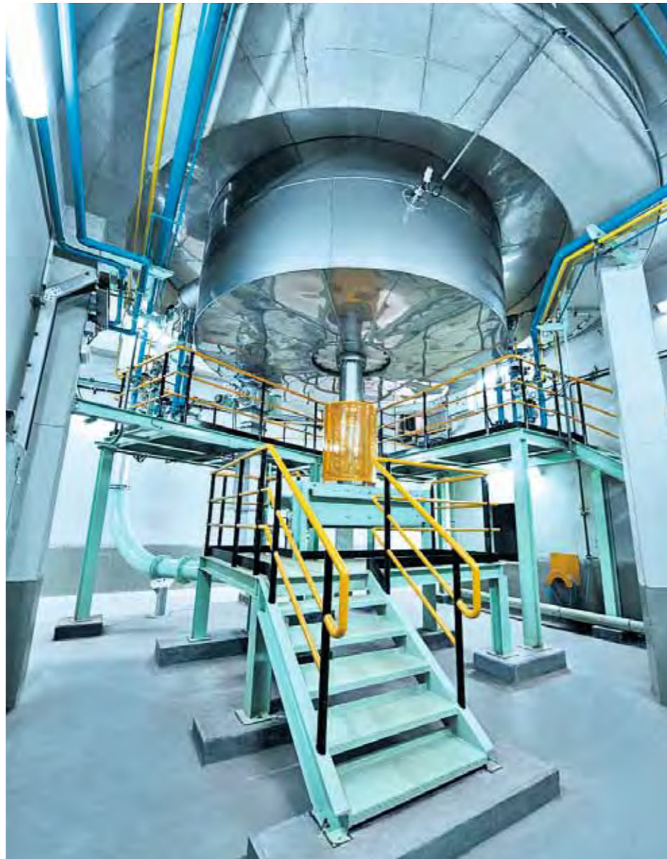
▲ PYROMARS反应炉基座
