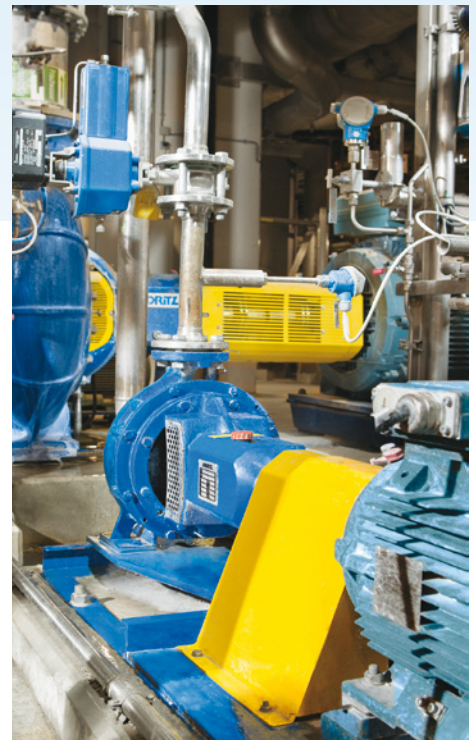
Installierte ANDRITZ Pumpen Serie ISO
