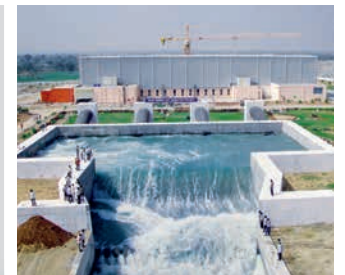
Kalwakurthy Stage 2, Indien Großpumpen (5 x 30 MW, 5 x 23 m 3 /s) für landwirtschaftliche Bewässerung in Andra Pradesh 2016
