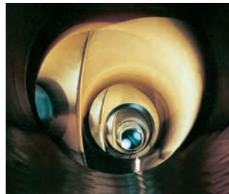
Tarbela Dam, Pakistan Weltgrößter Rohrabzweiger (Durchmesser 13,2 m; Höhe 16 m); Guinness Buch der Weltrekorde 1993
