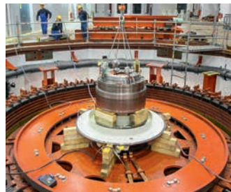
Goldisthal, Deutschland Erste asynchrone, drehzahlvariable Pumpspeichersätze außerhalb Japans 1997
