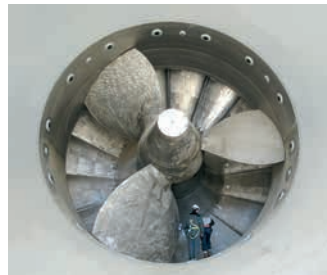
Sihwa, Korea Elektromechanische Ausrüstung inklusive zehn Rohrturbinen (je 26 MW) für das weltweit größte Gezeitenkraftwerk 2006
