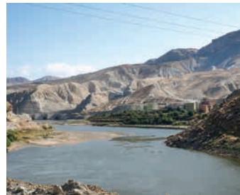
Ilisu, Türkei Elektromechanische Ausrüstung für das größte Wasserkraftwerk in Südostanatolien 2008
