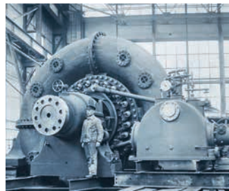
Niederwartha, Deutschland Elektromechanische Ausrüstung für das erste Pumpspeicherkraftwerk der Welt 1929
