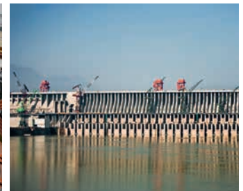
Three Gorges (Sanxia), China Turbinen und Generatoren für das größte Wasserkraftwerk der Welt 1997
