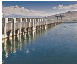
Ashta, Albanien 90 Module für das weltgrößte HYDROMATRIX®-Kraftwerk (Ashta I mit 24 MW, Ashta II mit 45 MW) 2008
